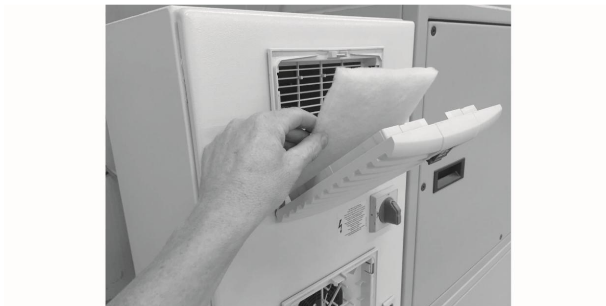
Fig. 39: Cambio del filtro del armario de distribución
